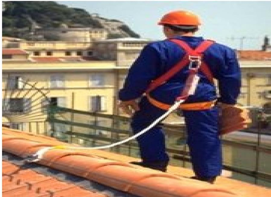
**Il sistema di arresto caduta comprende il punto di ancoraggio (sicuro) e il DPI contro le cadute dall'alto**
