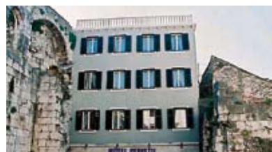
Hotel Peristil Split (Croazia)
