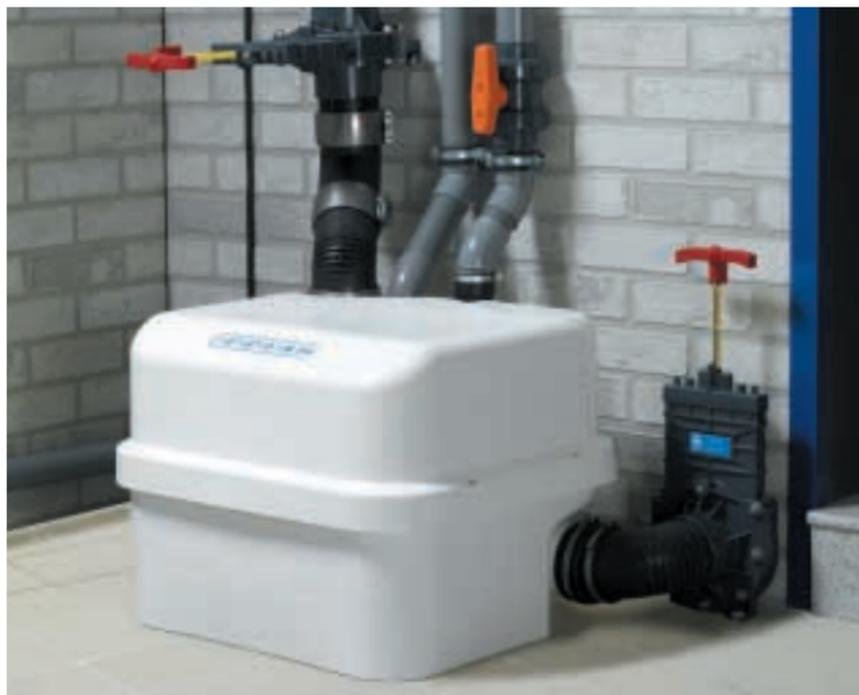
La stazione di sollevamento capace di scaricare tutti i sanitari di una abitazione. Questo nuovo trituratore/pompa è in grado di gestire le acque reflue e di scaricarle con tubi di soli 50 mm di diametro.
