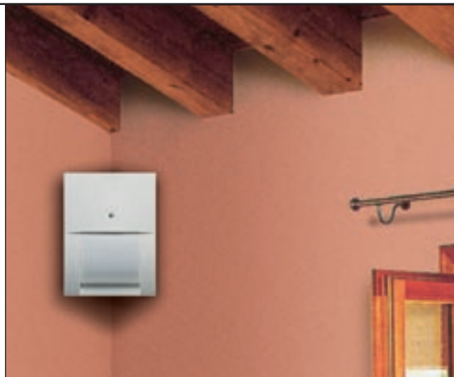
Installazione angolare dei rivelatori IR
