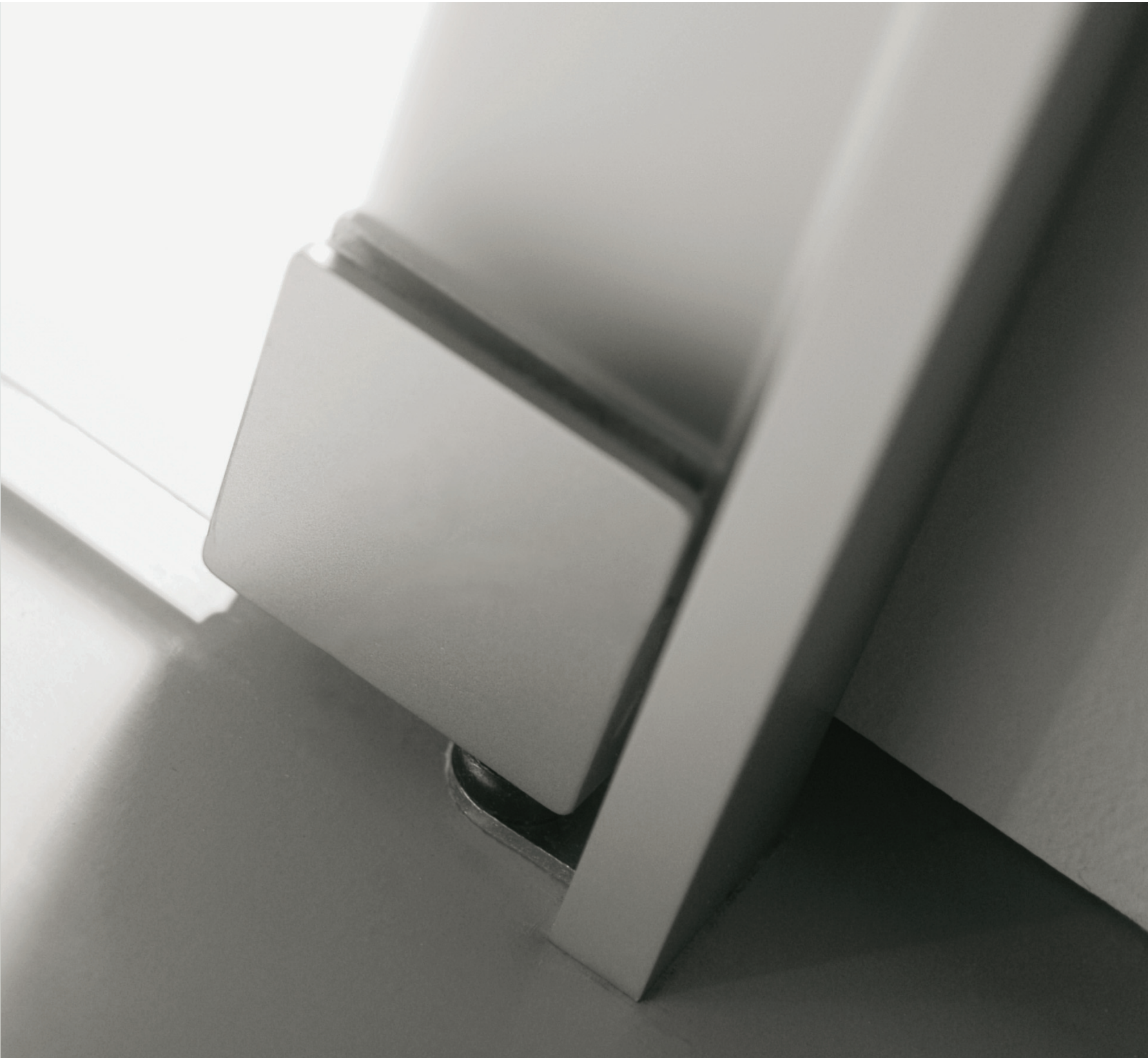
Particolare della piastra per maniglia con serratura e della cerniera color alluminio.
