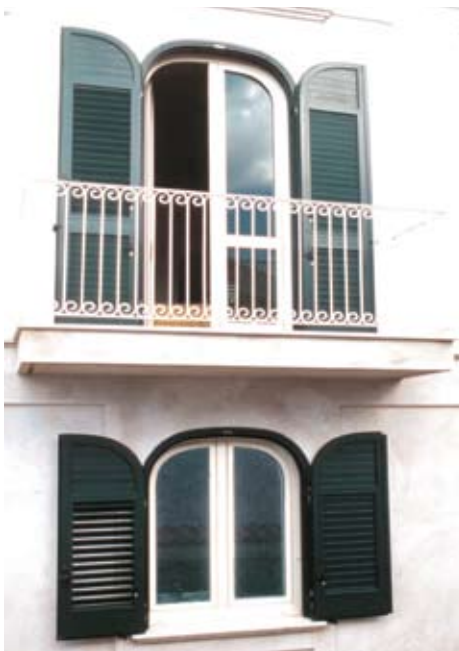
Persiana a doghe orizzontali nella parte superiore e stecche orientabili nella parte inferiore.
