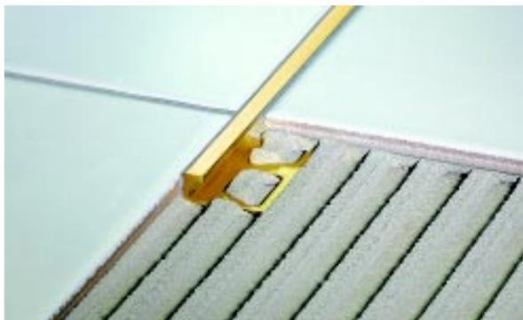
La parte metallica esposta è soggetta a fenomeni di ossidazione che provocano una patina sull'ottone. In presenza di elevati tassi di umidità o agenti molto aggressivi la superficie può essere soggetta ad ossidazione elevata ed alla presenza di macchie.
