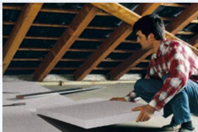
Le lastre in Neopor® posate nei solai proteggono i vani sottostanti dalle dispersioni termiche.
