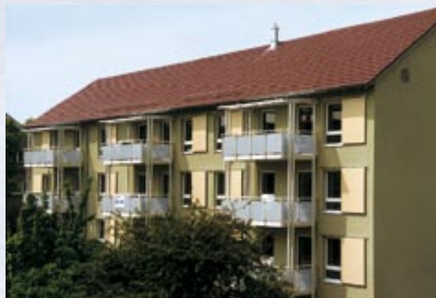
La nuova facciata della casa 3 litri a Ludwigshafen.
