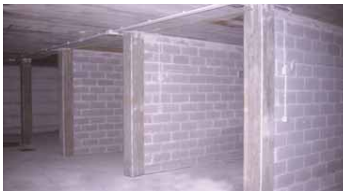
Parete tagliafuoco di garages con blocchi in argilla espansa.
