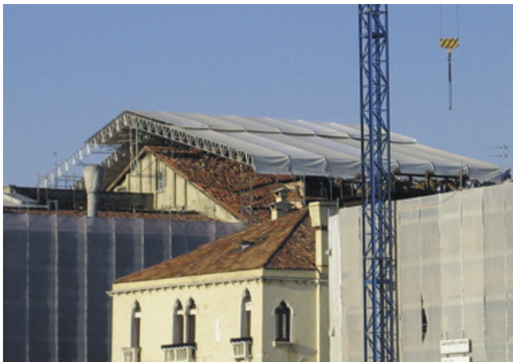
Cantiere: Edilnoleggi Valente S.r.l. in Venezia
