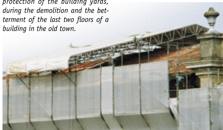
Cantiere: Edilnoleggi Valente S.r.l. in Rovigo
