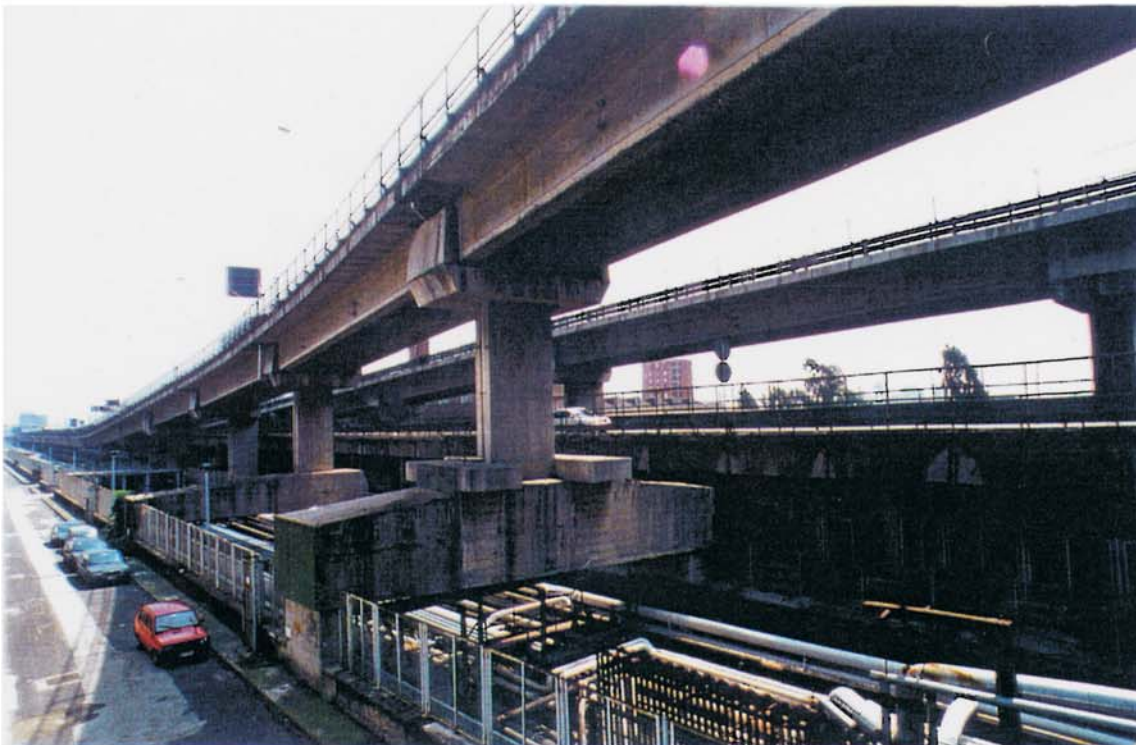
Fig. 2.1.2 veduta dei viadotti sovrastanti via Argine
